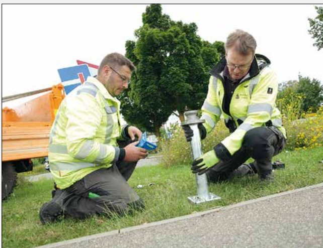
Neues Eigenprodukt TerraQuick im Einsatz (betonfreie Verankerungen)
